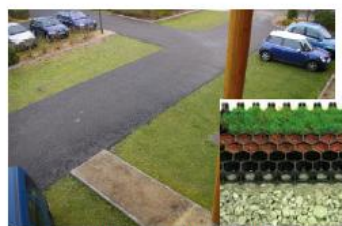
parking dalles alvéolaires enherbées
