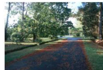
voirie et fossés latéraux
